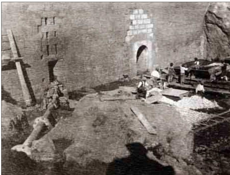
En aquellos momentos (1908) hacía más de 30 años que no se abría la compuerta de limpieza de fangos, por lo que se había producido el aterramiento del vaso y los lodos alcanzaban junto a la presa una altura de 13,5 m, “...excepto en el pequeño embudo formado al aplomo de la toma de aguas o Botana, para impedir el aterramiento de la cual se deja constantemente salir agua por ella...”. Como
