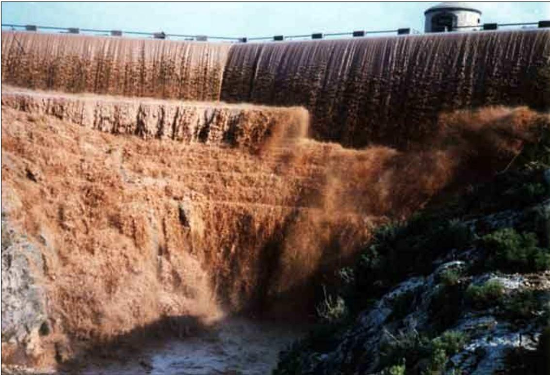
A finales de los años setenta, para abrir la compuerta de toma de riego (Botana), ya era necesario remover previamente con un compresor los sedimentos acumulados en torno a las aspilleras del paramento de aguas adentro. En noviembre de 1984, tras unas copiosas lluvias que provocaron el desbordamiento de la presa, se intentó abrir
