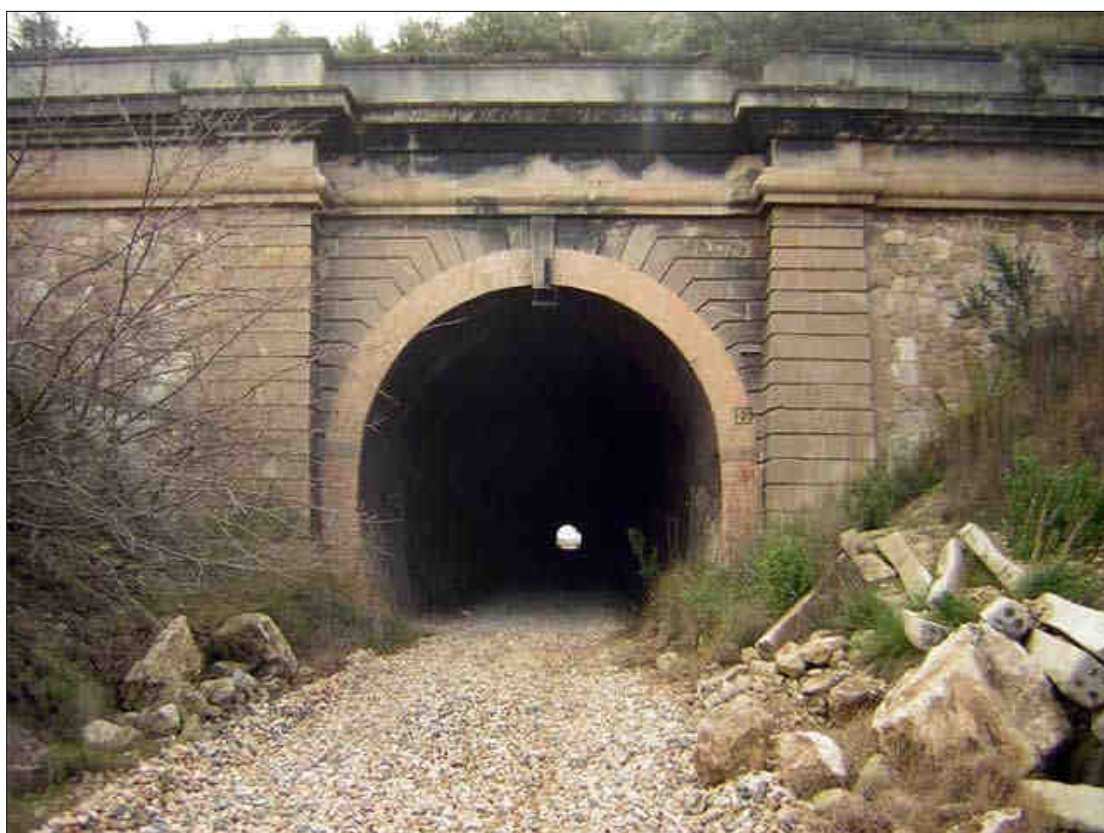
Bocas del túnel de Santa Bárbara
