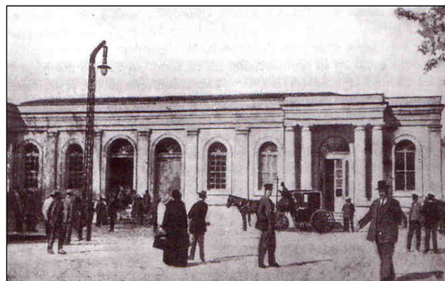
Valencia, estación del Norte
