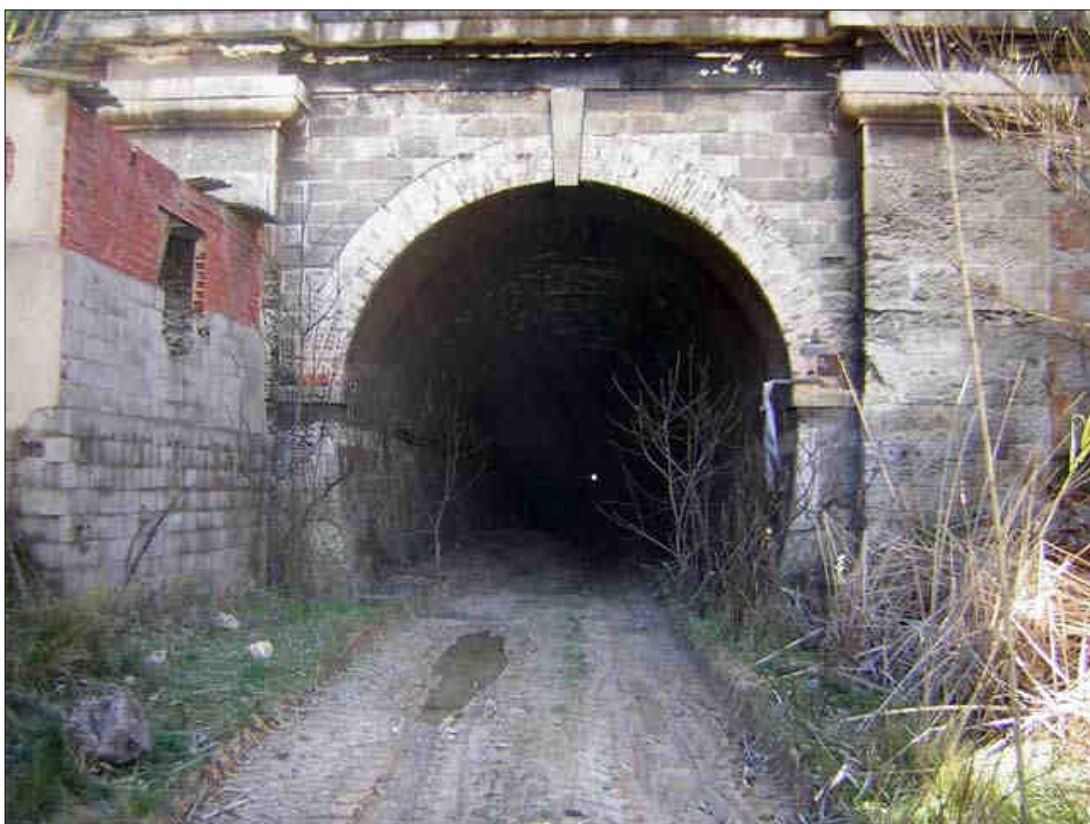
Bocas del túnel de Mariaga
