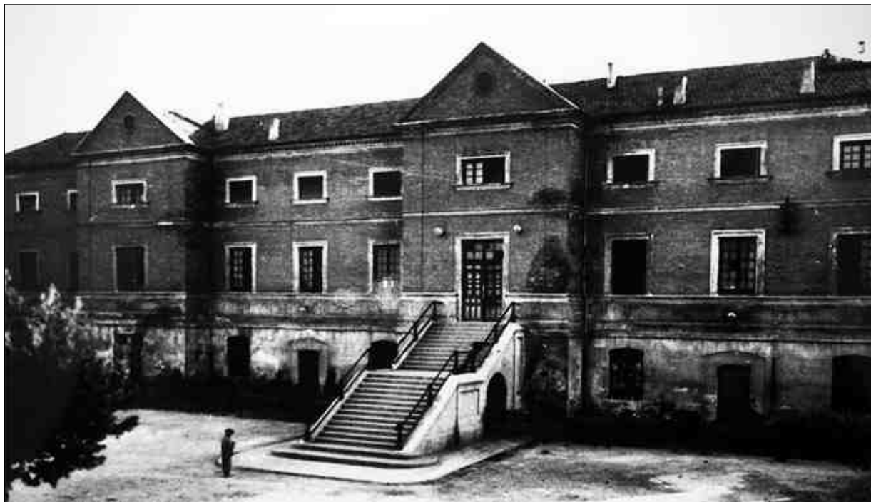
Antigua estación de Almansa
