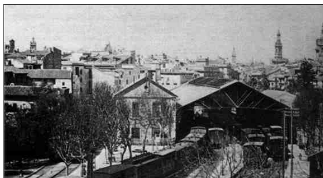
Valencia, estación del Norte
