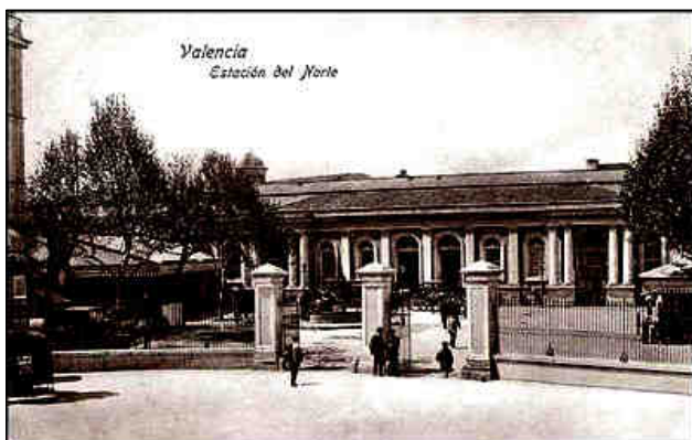
Valencia, estación del Norte
