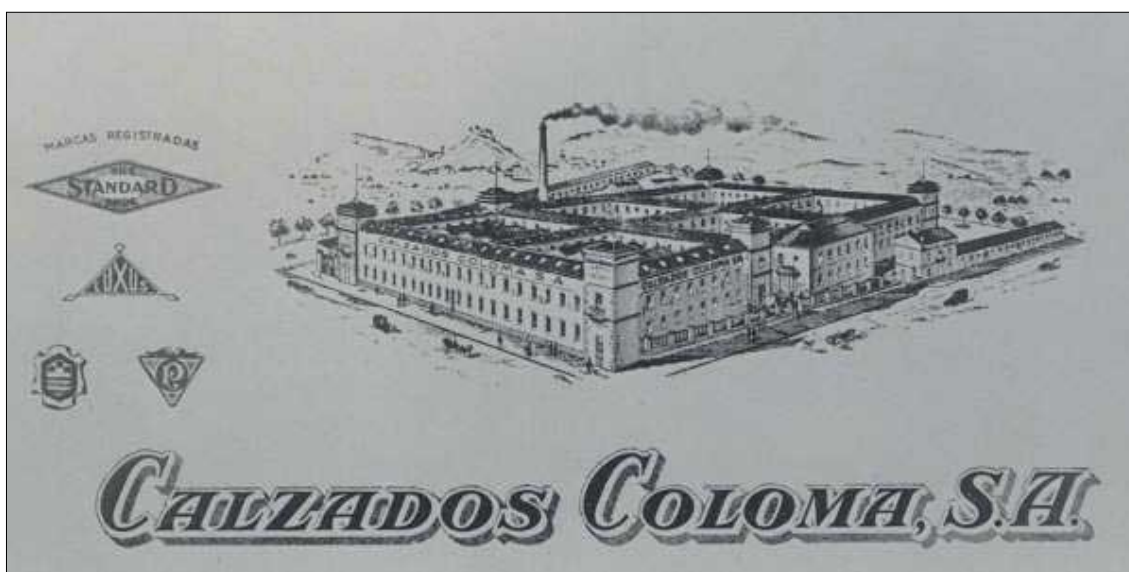
Fot. 4.- Chimenea industrial
