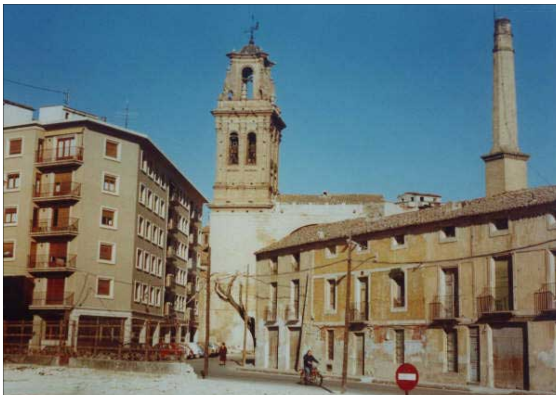
Fot. 9.- Chimenea industrial
